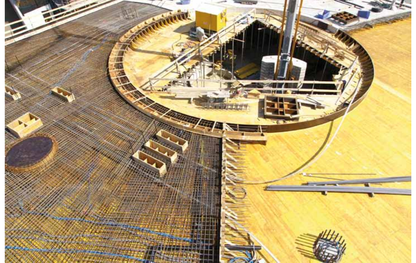
Zweite Etappe des Daches kurz vor dem Betonieren
