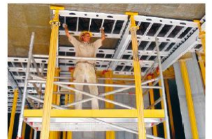
1 Zeitgemässes System: Schalung und Ausschalung von unten.
