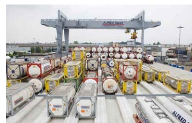
Stand der Technik bei der Containerlagerung: Auffangwanne und Containerterminal TALKE in Hürth/Köln.
