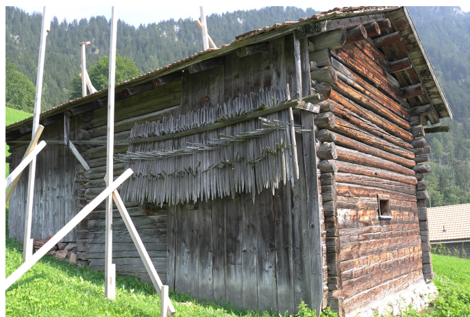
Abb. 1: Ansicht kurz vor Abbruch.
