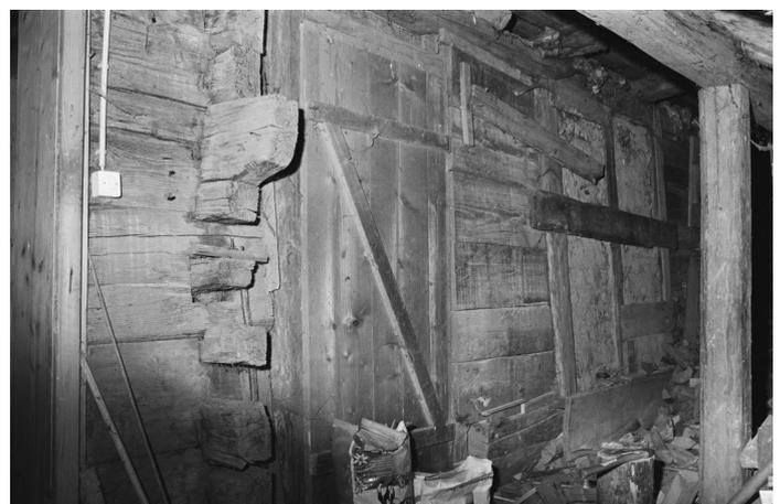
Abb. 4: Westwand des Obergeschosses in St. Georg-Strasse 33 in Mischbautechnik von 1832 mit von links nach rechts überkämmt Blockbauecke, Bohlenständerwand und Lehmflechtwerkwand.
