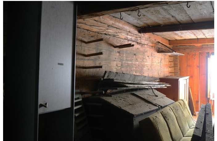
Abb. 4: Wohnhaus-Nordwestwand von 1729 in Blockbauweise. Die Holzdübel dienen einem Weber als Zettelbaum.
