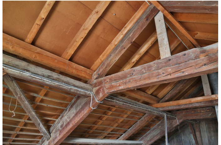
Abb. 5: Wohnhaus-Dachstuhl von 1864, 1935 geschiftet und mit neuem Rafenwerk überdeckt.
