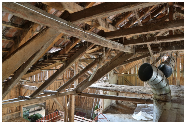
Abb. 7: Scheunen-Ersatzbau von 1854; hinten links Scheunen-Erweiterung von 1940 unter Quergiebel.
