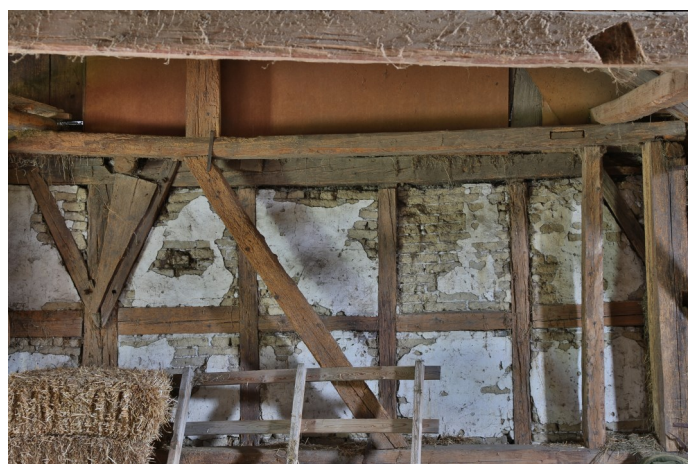
Abb. 4: Wohnhaus-Nordwand von 1619 in Sichtfachwerk, mit Kopfbändern versteift.
