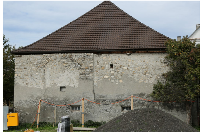
Abb. 8: Die Südfassade der Stallscheune mit Anzeichen verschiedener Bauetappen. Die Rundbogenöffnung war ursprünglich mit einer Holzwand geschlossen.
