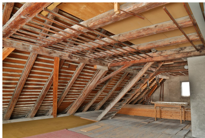
Abb. 4: Der Dachstuhl über dem Gasthaus, errichtet 1796.
