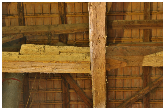
Abb. 7: Am Scheunen-Dachstuhl von 1796 sind weitgespannte Balken mittels Hakenschlössern verlängert.
