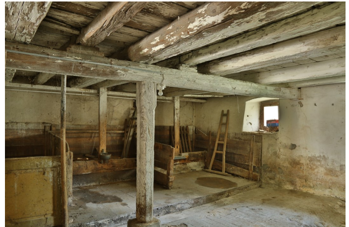
Abb. 5: Die Stallanlage mit Platz für zeitweilig bis zu vierzig Pferden, im frühen 20. Jahrhundert zum Viehstall umgenutzt.
