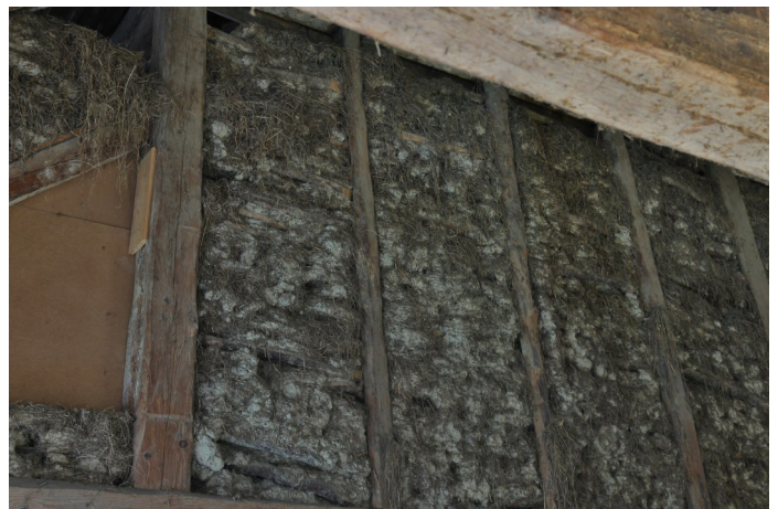
Abb. 5: Eine Lehmwickelwand von 1832 trennt den Scheunenraum vom Wohnhaus-Dachgeschoss.
