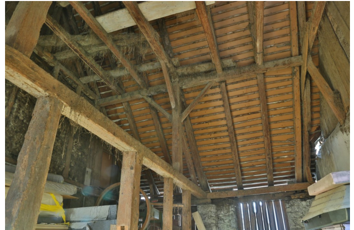
Abb. 4: Dachstuhl von 1832 über der Scheune, in stehender Art abgebunden.
