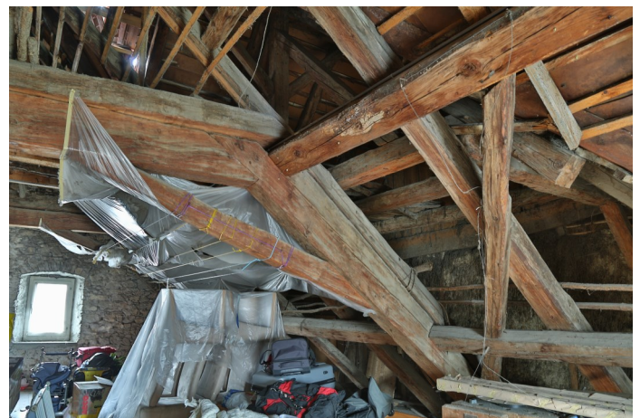
Abb. 3: Dachstuhl von 1796 über dem Wohnhaus: Freibinder liegender Art, eine von Streben überkämmt Zwischenpfette sichert die Längsversteifung.
